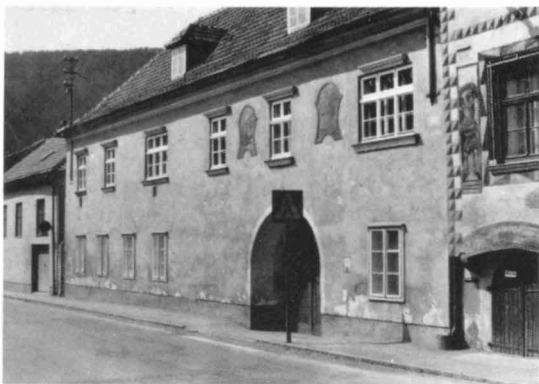
Der neuzeitliche (16. Jh.) Herrschaftshof, zugleich Verwaltungswohnung, im „Unteren Markt“ von Senftenberg.
