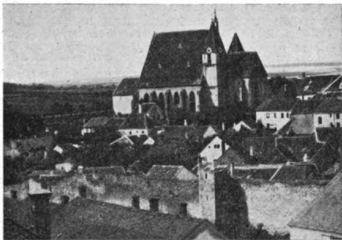
Südseite der Pfarrkirche.
